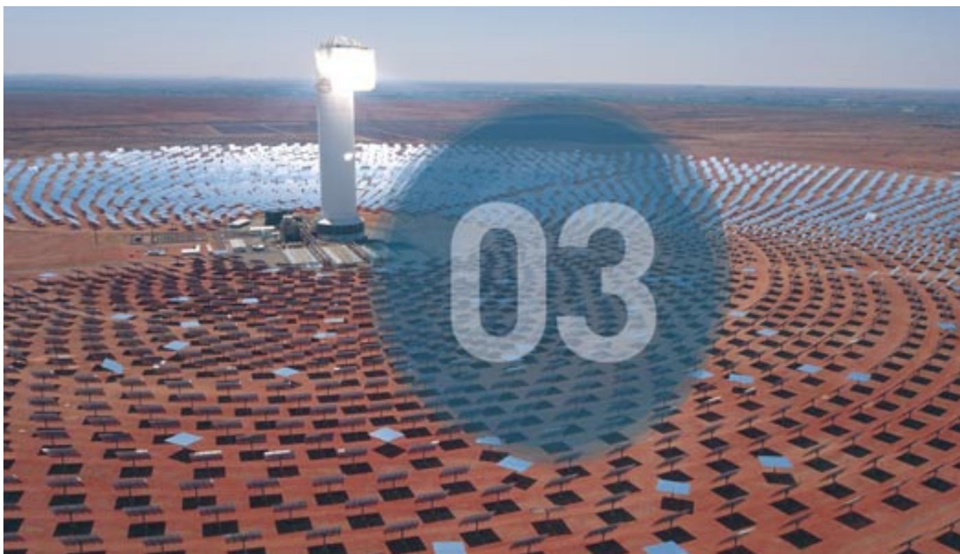
Centrale électrique solaire alimentant le réseau national à Upington, Afrique du Sud. © Nicole Macheroux-Denault / Shutterstock
