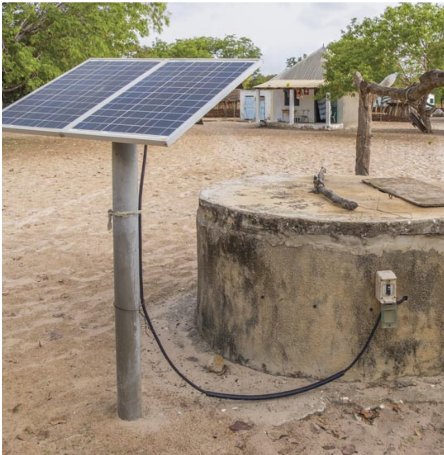
Puits et panneau solaire dans le centre d'une petite ville de l'île de Sipo, au Sénégal. © Salvador Aznar, Shutterstock
