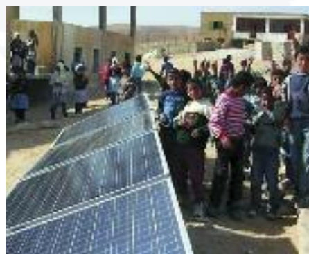
Escolares en la aldea árabe Rahayda al este de la ciudad de Belén. Los paneles solares le dan energía a la escuela para iluminación.
