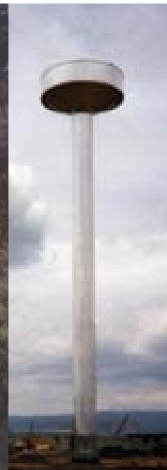
Torre de agua.
